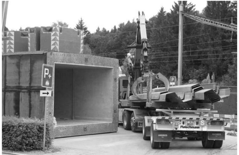
Bahnhof Rikon, 13.7.2012: neben dem Kiosk stehen die 4 vorgefertigten Teilstücke der Unterführung
