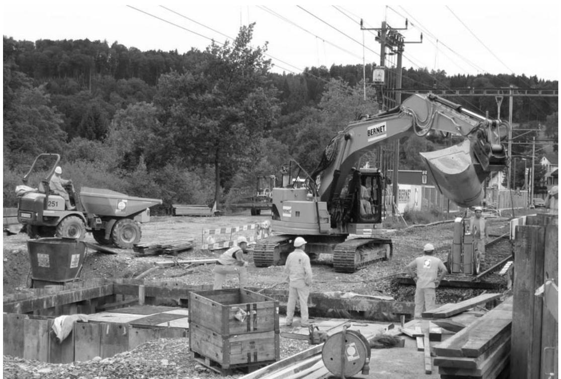
Bahnhof Rikon, 15.7.2012: die Arbeiter stehen auf der Unterführung, die 4 Teilstücke sind in der Baugrube platziert und wasserdicht zusammengespannt. Am nächsten Morgen muss der Zug wieder fahren.
