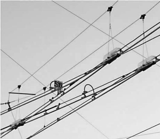
Die Weichen bestehen aus feststehenden Anschlussstücken und beweglichen Zungen. Die Bewegung der Zungen erfolgt ausschliesslich durch Elektromagnete. Der Ablenkwinkel beträgt im Normalfall 20° (zwei Weichenstücke). Wo hohe Ueberfahrge-schwindigkeiten gefordert werden (z.B. Einspurstrecken), wird mit einem Winkel von 10° und einem zusätzlich geschalteten Kreuz gearbeitet (drei Weichenstücke). Kreuzungweichen mit 20° werden eingesetzt, wenn von zwei Fahrspuren wieder
