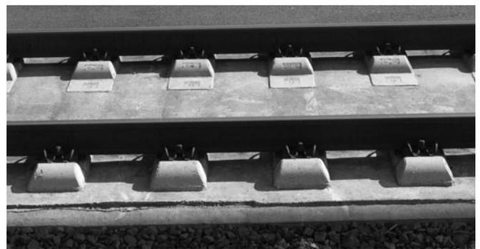
Abbildung 4: Feste Fahrbahn auf der Neubaustrecke zwischen Erfurt und Halle (Saale) [4]
