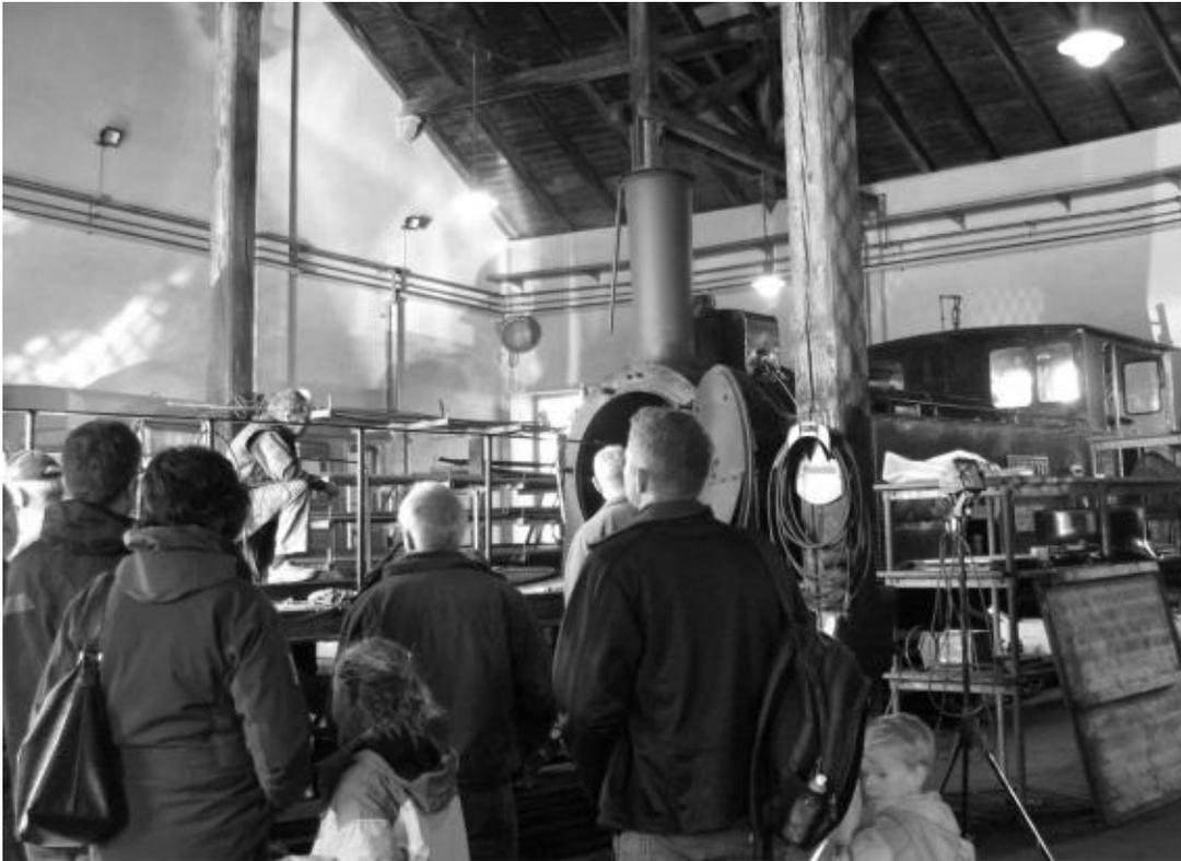
Wir schauen zu, wie eine Dampflokomotive revidiert wird. Der frontseitige Deckel des runden Kesselgehäuses ist geöffnet. Ein Mitarbeiter russt die Rohre, durch die das glühende Rauchgas zieht und dabei das Wasser im Kessel so stark erhitzt, dass es sich in Dampf verwandelt.
