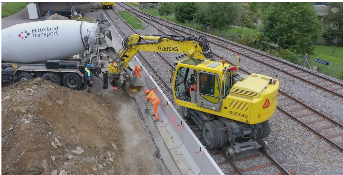
Abbildung 5: Der neue Bahnperрон in Triengen im Bau. Die Sockelelemente werden montiert
