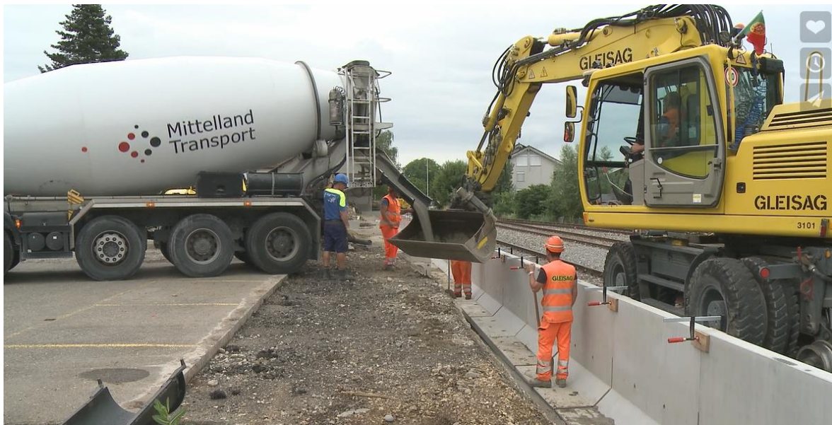
Abbildung 4: Der neue S-Bahn-taugliche Bahnperрон in Triengen im Bau (u.a. 55-cm)
