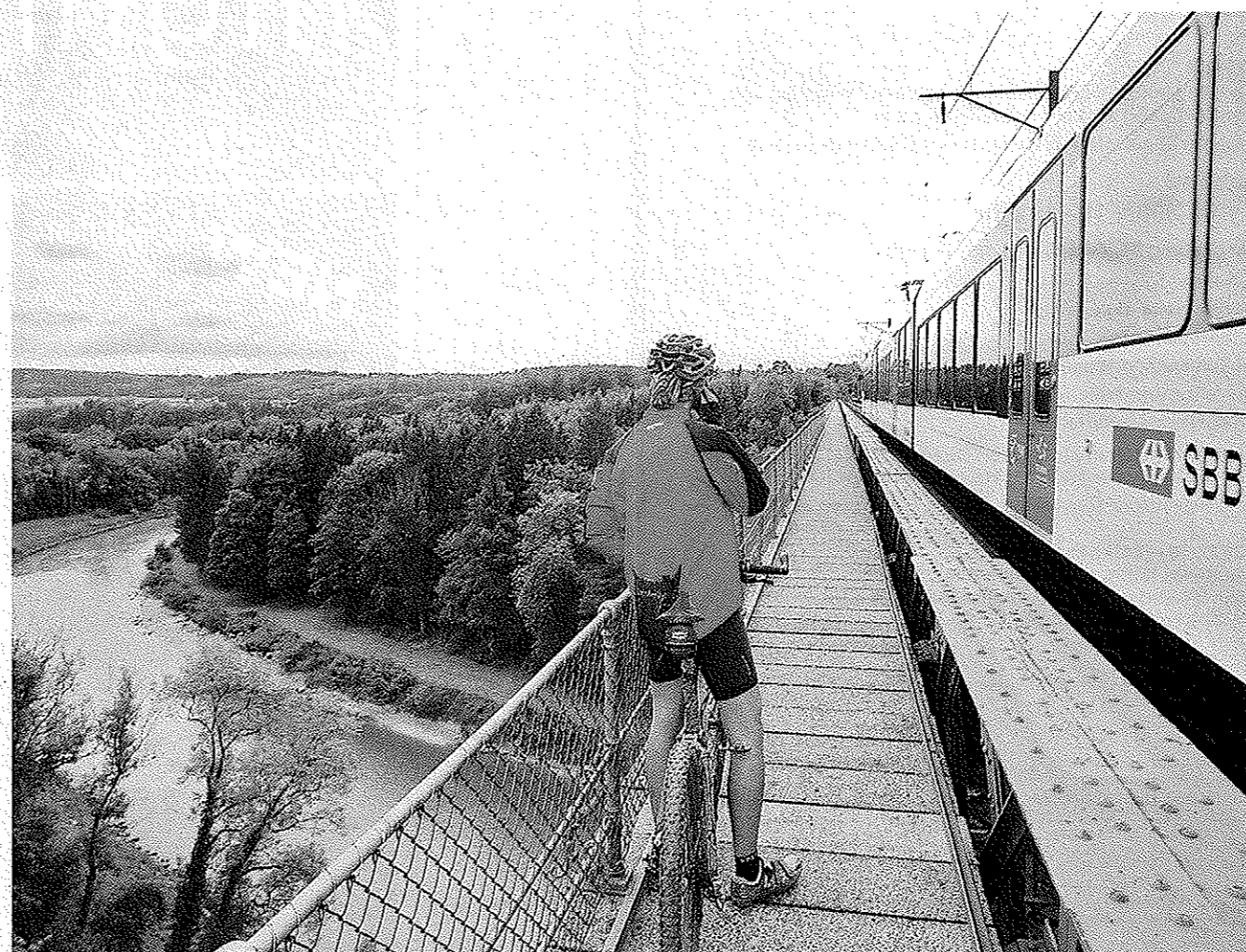
Auf der Stammer Linie – hier die Brücke über die Thur – fährt noch jahrelang nur ein Zug stündlich in jede Richtung.
