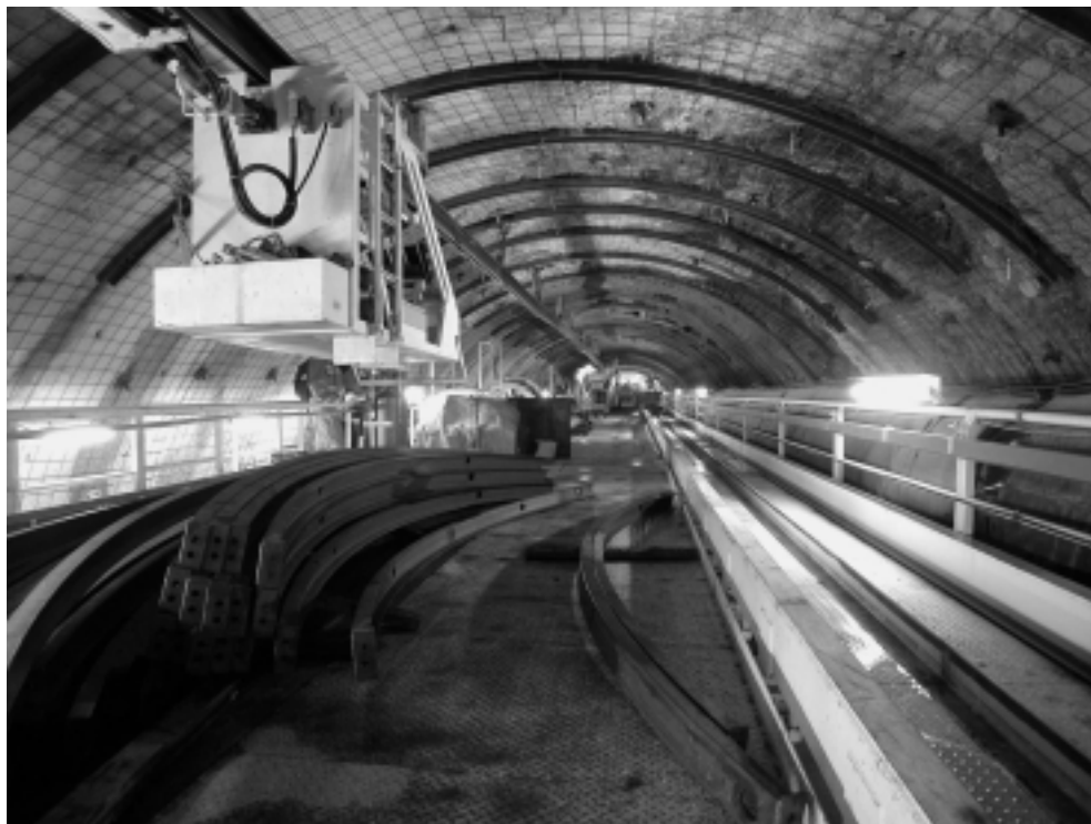
Bild AlpTransit: Monorail zur Tunnelbohrmaschine
