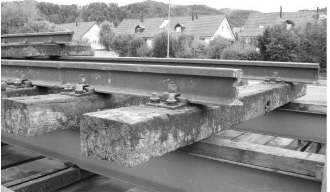
Schotterbett. Die Arbeiter schrauben die neuen Schienen darauf fest. Danach verschweissen sie das Ende jeder Schiene mit dem Anfang der nächsten. Auf der Strecke zwischen Rämismühle Zell und Turbenthal waren bisher in den Kurven die Schienen nicht verschweisst, und dadurch wurde man als Fahrgast richtig durchgeschüttelt und die Schläge auf die Räder erzeugten laute Knallgeräusche.
