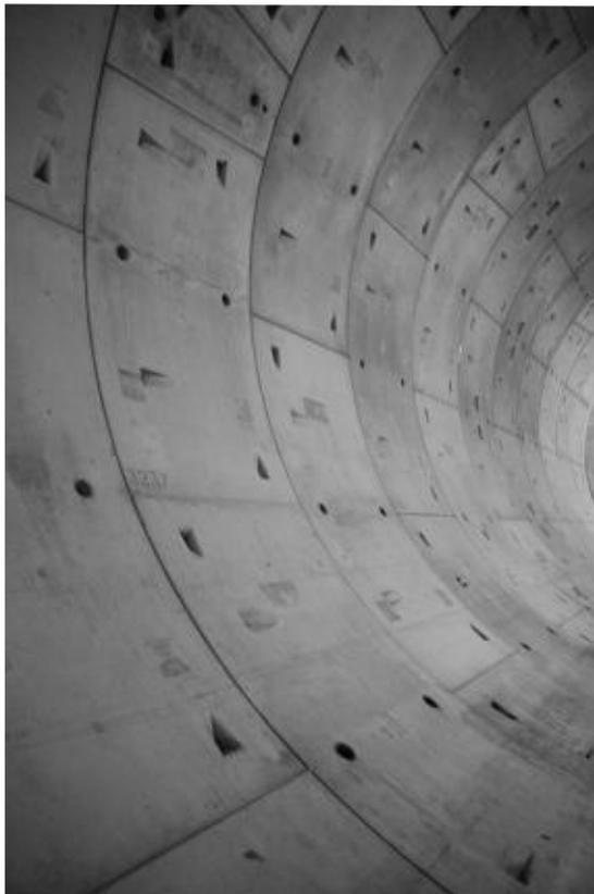
Tübbinge nach dem Einbau mit Hilfe einer TBM [3]
