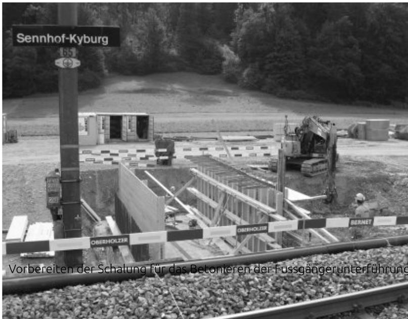
Vorbereiten der Schalung für das Betonieren der Fussgängerunterführung
