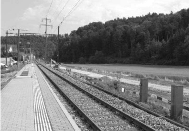
Verbreitern der Böschung für die Platzierung des zweiten Gleises
