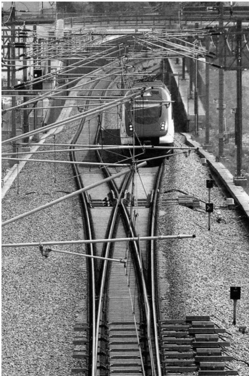
Abbildung 2: Schnellfahrweiche für 200 km/h auf der Ausbaustrecke Wanzwil - Solothurn [3]
