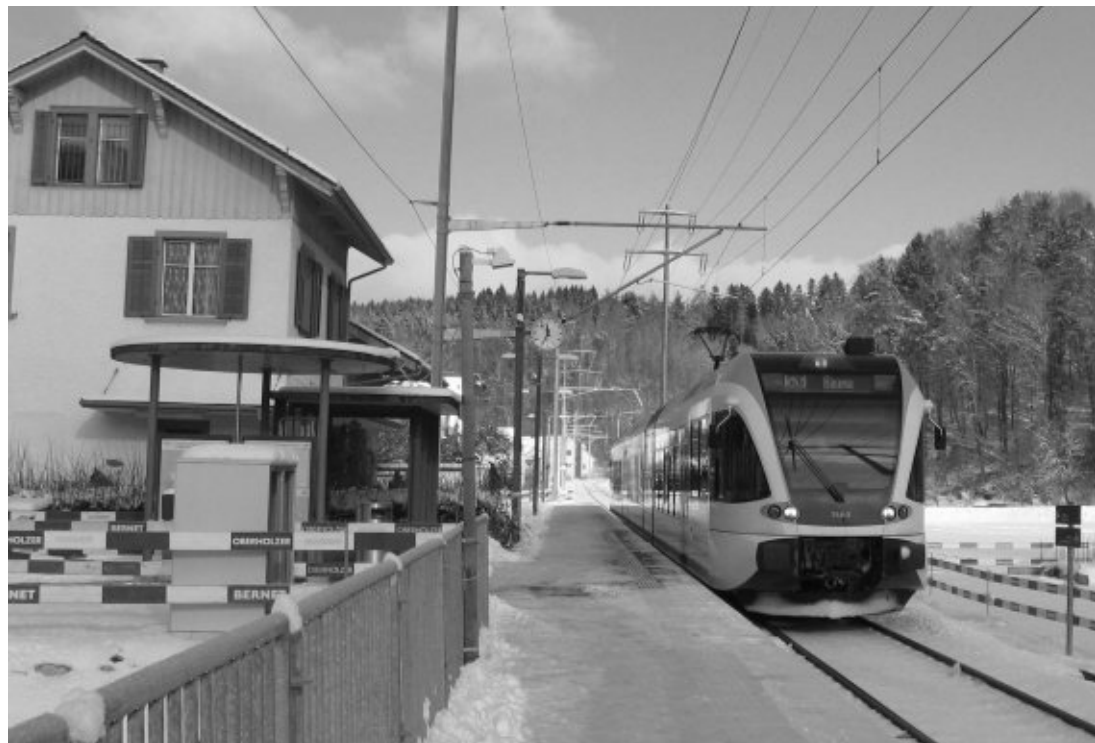
Der Bahnhof Sennhof-Kyburg wird auf den Fahrplanwechsel 2018 zur Kreuzungsstation mit einem 170 Meter langen Aussenperron umgebaut.
