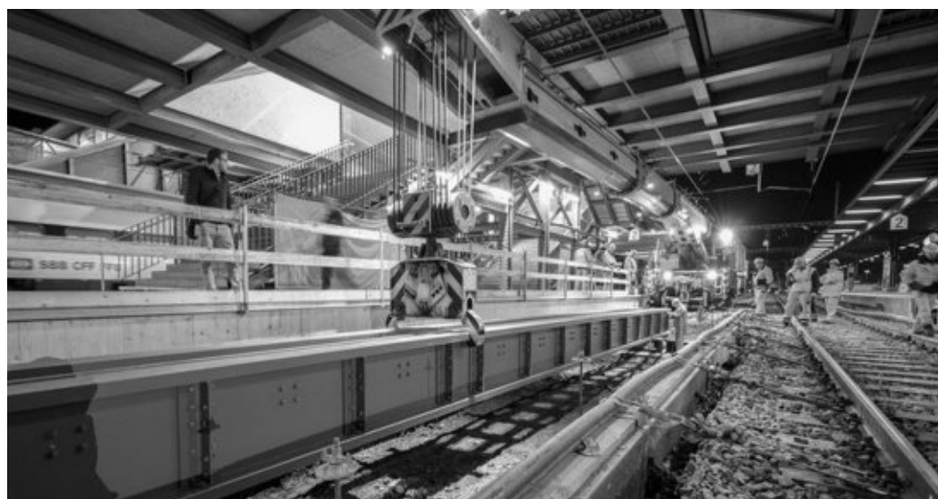
Einlegen der Gleishilfsbrücke über die Baugrube beim Gleis 4 im November 2018 Bild © SBB
