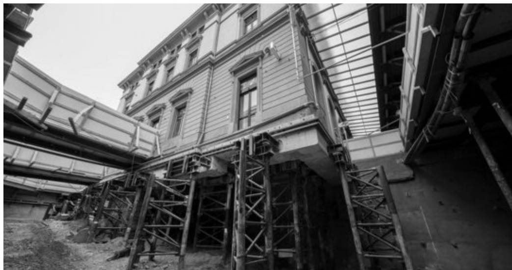
Für den Bau der Velounterführung musste das Bahnhofsgebäude abgestützt werden Bild © SBB
