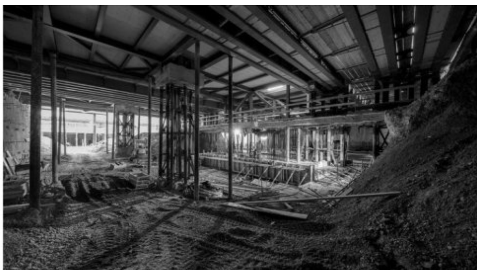
Unter dem Bahnhof entsteht die neue Personen- und Velounterführung Bild © SBB
