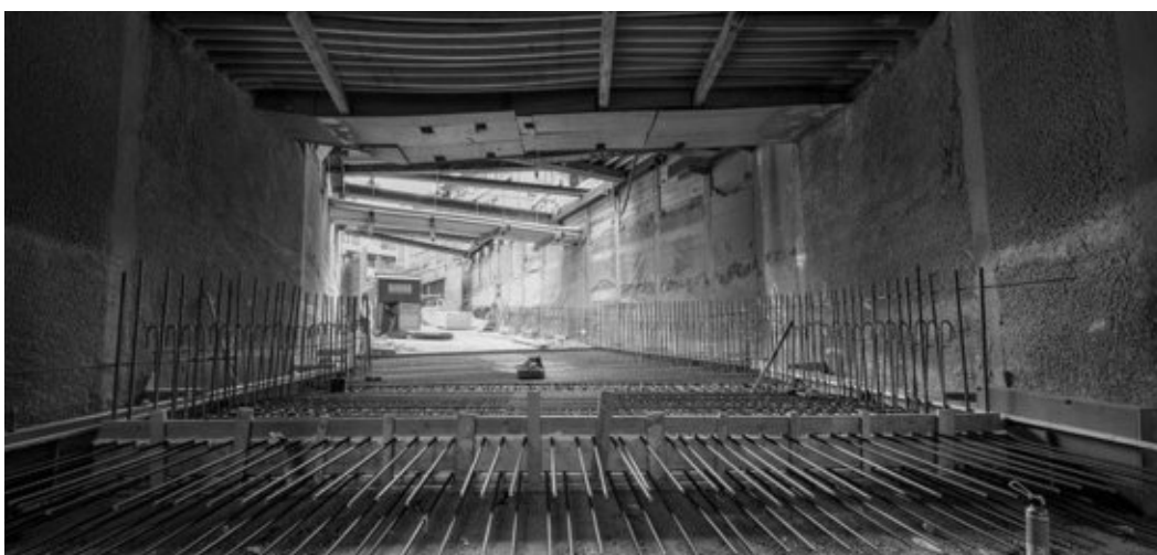
Juli 2019: unter dem Bahnhofplatz entsteht die neue Velounterführung Bild © SBB
