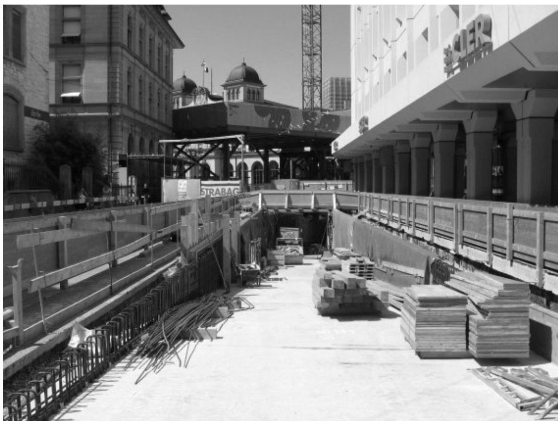
Die Rampe der Velounterführung von der Bank- zur Wartstrasse am 3. August 2019
