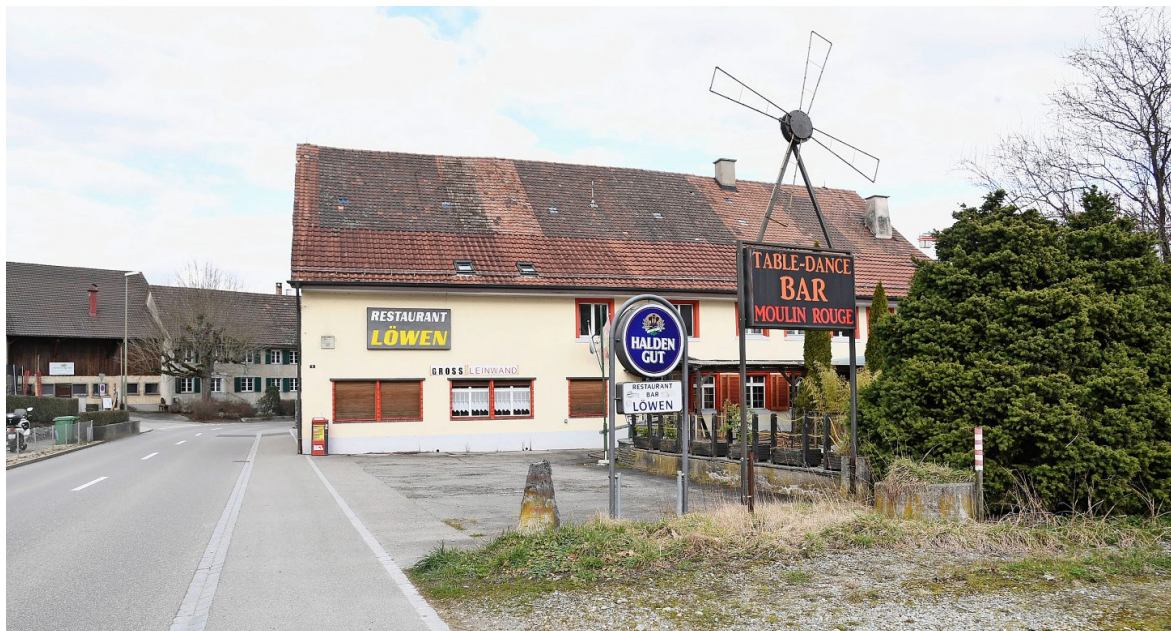
Einige Bauteile des einstigen Restaurants Löwen in Ellikon an der Thur sind laut Gutachten schützens- und erhaltenswert. Diese befinden sich auf der Ostseite (r.). Foto: M. Schoder
