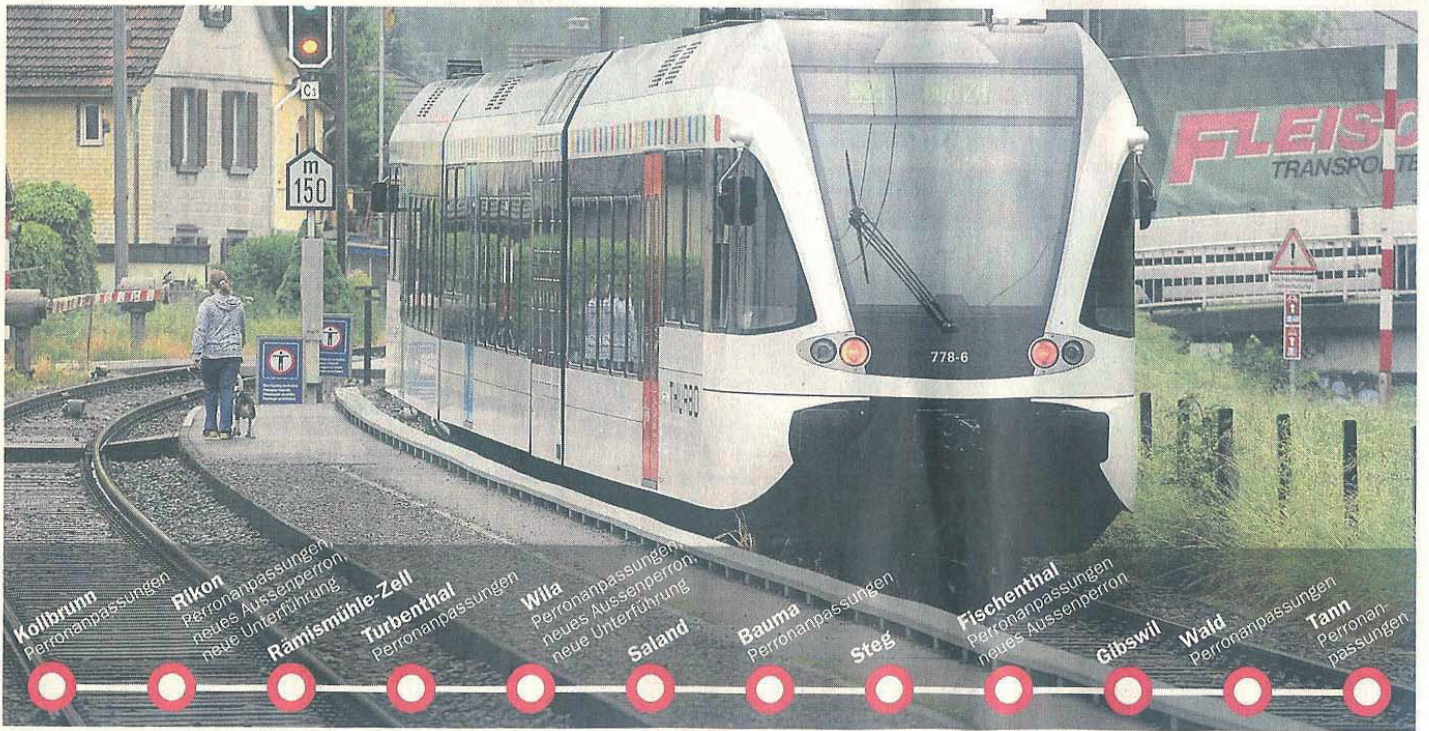
Die Fahrgäste sollen einfacher ein- und aussteigen können, wenn sich in Rikon und Wila die Züge kreuzen. Die SBB bauen darum Perrons und Unterführungen. Bild: Heinz Diener
