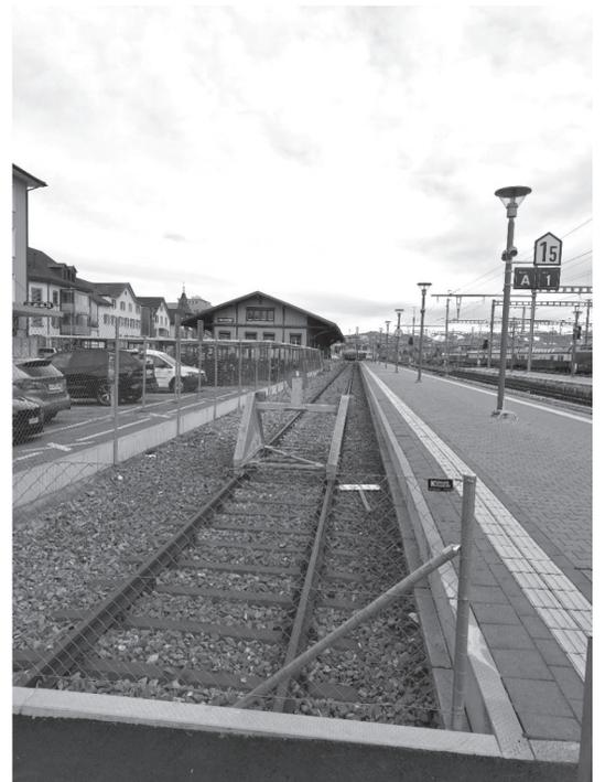
Gleis 0 mit einem vollständig ausgebautem 55-cm-Perron, jedoch ohne Fahrdraht.
