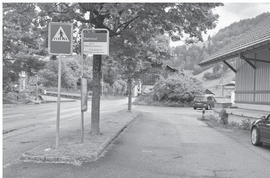
Beispiel Bushaltestelle «Bahnhof» in Gibswil. Keine Bus-Kante vorhanden. Die Fahrgäste treten mit einem grossen Höhenunterschied vom Bus direkt auf die Fahrbahn. Diese Haltestelle dient der VZO-Linie 854 in beiden Richtungen
